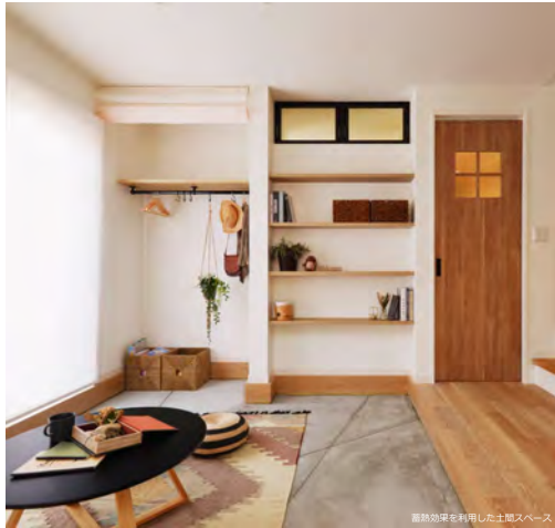
蓄熱効果を利用した土間スペース
