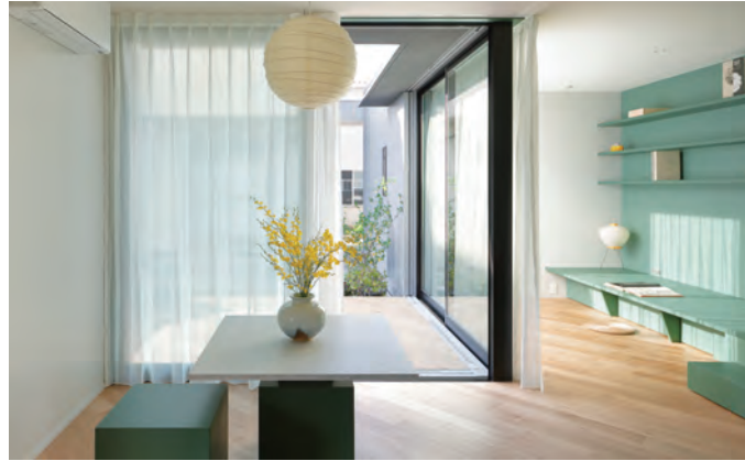
ダイニング側からゴロゴロベースとテラスを見る。内部のオーク材フローリングと外部の杉材ウッドデッキの中と木目、色を統一した。既存家屋に向かうように45度斜め貼りにし、内外の空間が連続する。自然採光・通風が良好な環境で、子どもたちは個室に閉じこもることなく、家族皆で勉強や遊び、食事、昼寝の時間をともにできる。
